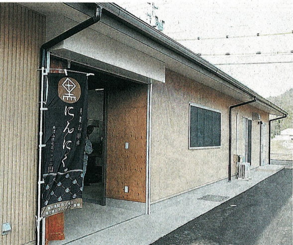
完成した美濃山県元気ファームの建物
